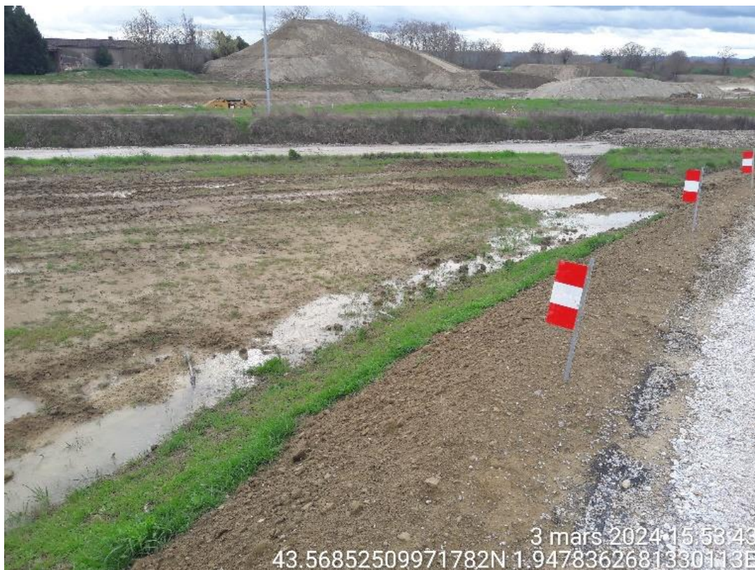
Figure 60: BP36300 APPELLE (81). Le bassin est à gauche de la photo et se déverse sur la zone de chantier
