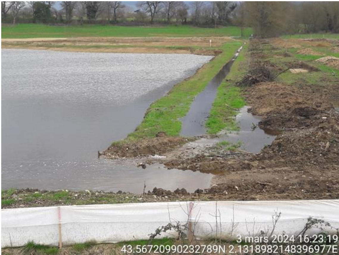
Figure 51: Fossé eaux pluviales en contact avec la nappe mise à l'air libre – SOUAL (81)
