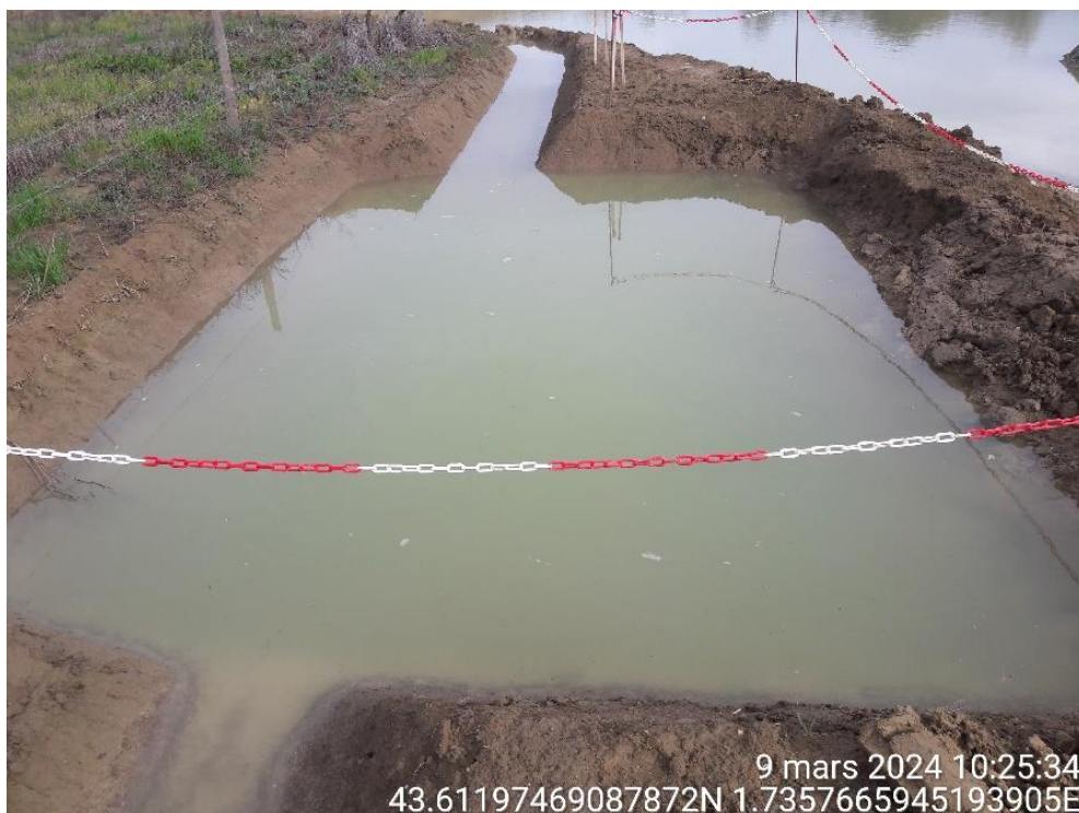
Figure 41: Nappe (en haut à droite) en contact avec le BP - MONTCABRIER (81)
