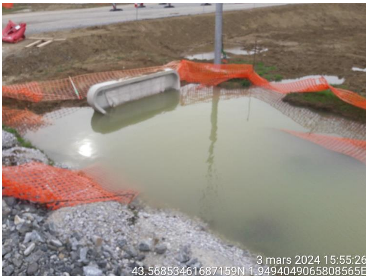
Figure 95: OH non indiqué sur les plans et totalement immergé (amont)
