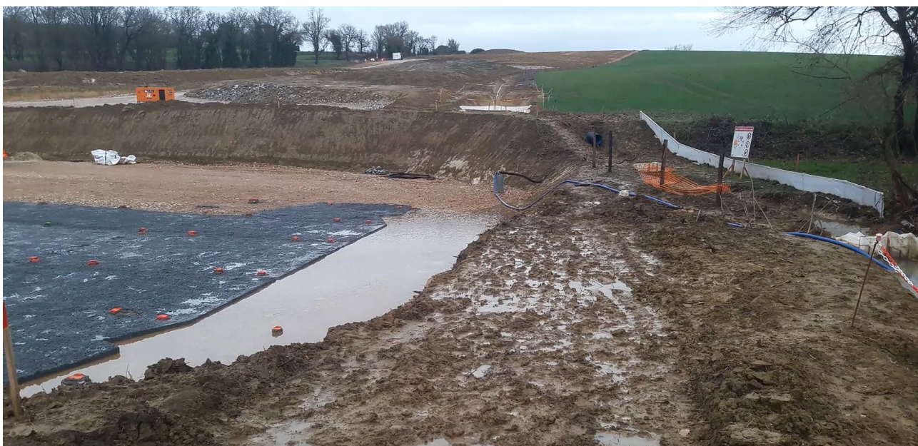
Figure 86: PUYLAURENS (81) le 10/02/2024 – Tentative d'assèchement de la nappe souterraine à partir du forage (à droite de la grande excavation), au moyen d'un tuyau de refoulement bleu, installé pour débiter dans le bassin temporaire, à droite de l'image
