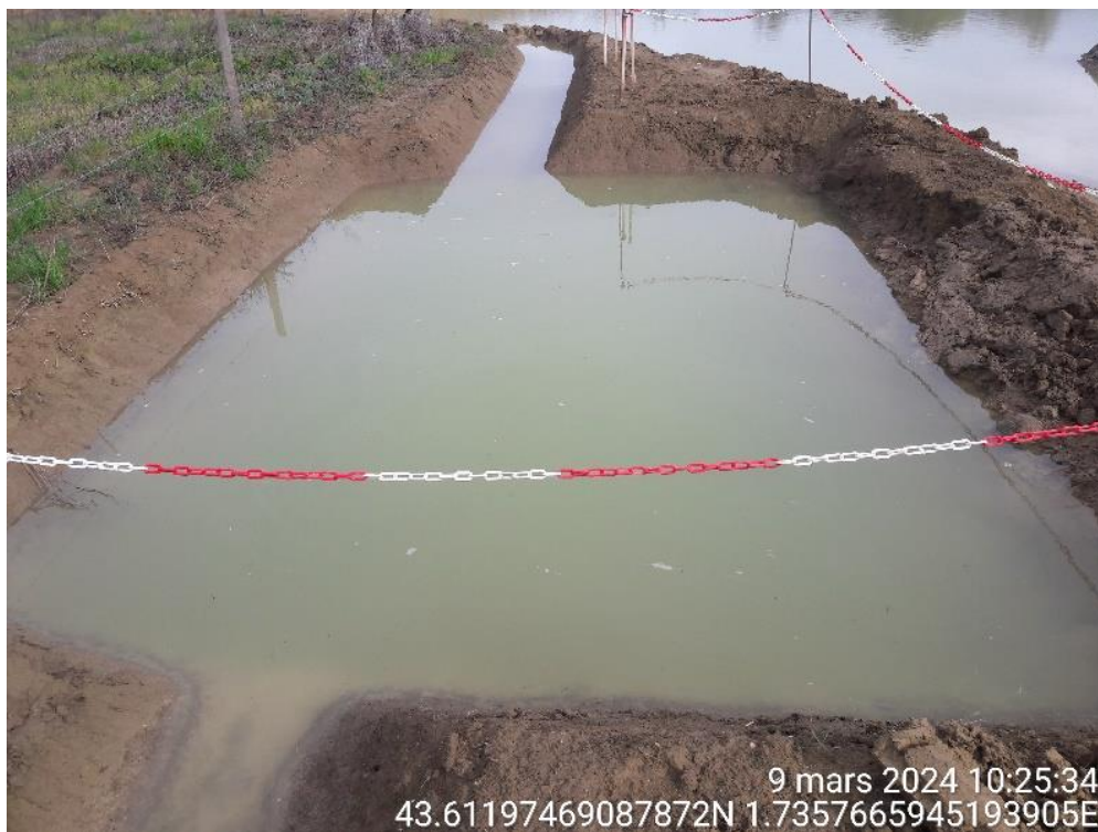
Figure 36: BP sans désignation ATOSCA MONTCABRIER (81) (érosion à droite)
