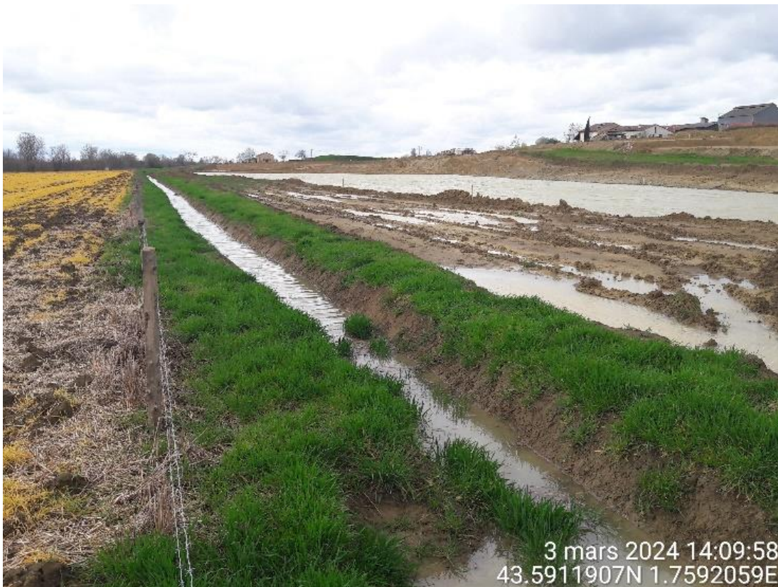
Figure 49 : Talus empêchant le ruissellement vers les fossés de collecte FRANCARVILLE (81)
