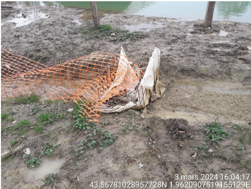
Figure 17: BP37450 Puylaurens (81) - pas de filtre à gravier, uniquement un filtre à paille
