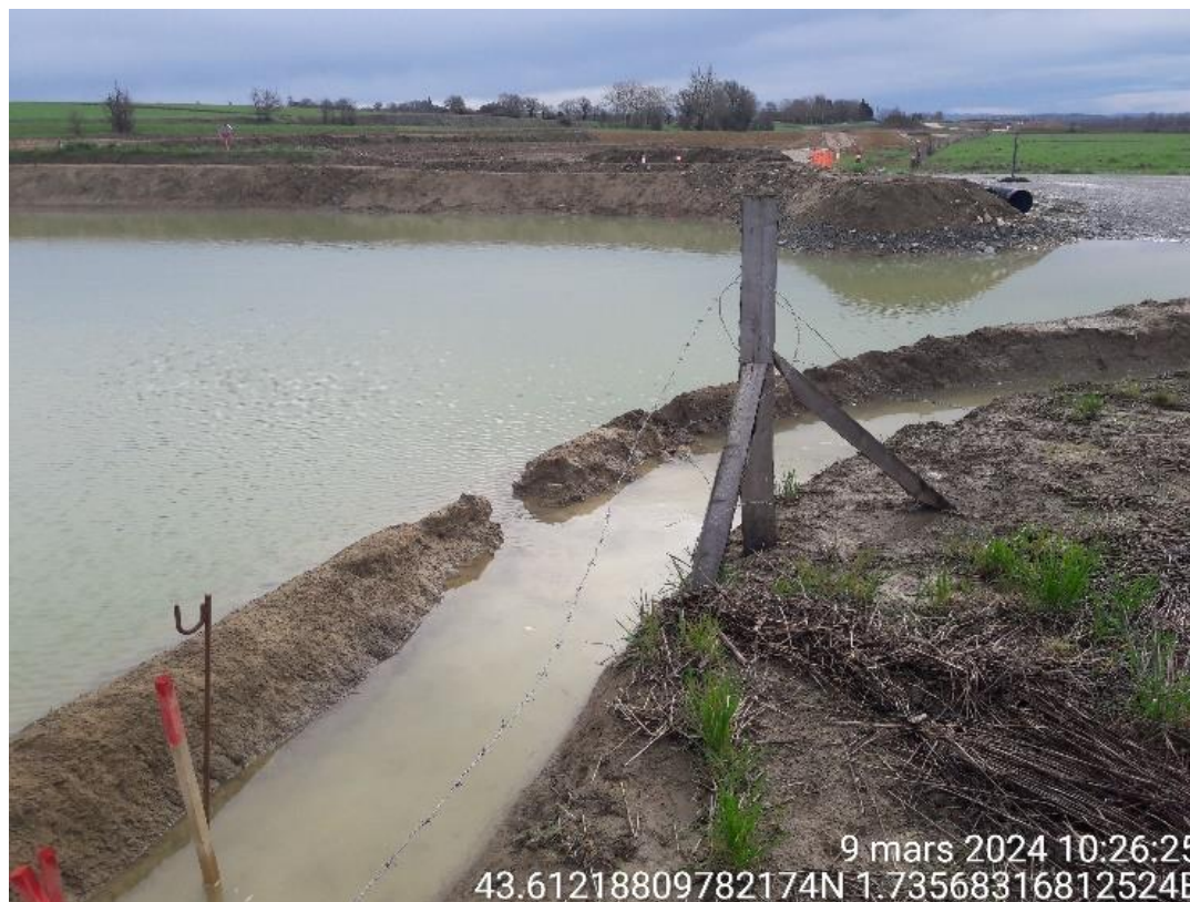
Figure 68: ouverture du fossé pour évacuation vers milieu récepteur - MONTCABRIER (81)
