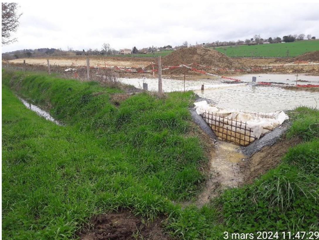
Figure 61 : BP13500S TEULAT (81) Fossé inondé (à gauche) - Point GPS 43.6276114,1.7018034
